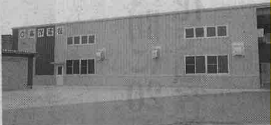
完成した第4工場
